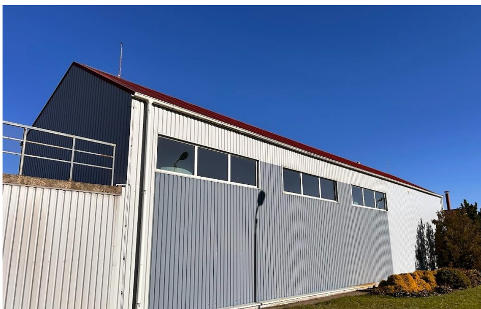
Attēls 2. Paredzētās saules elektrostācijas ēkas fotoattēls Ventas ielā 11/17, Liepājā
