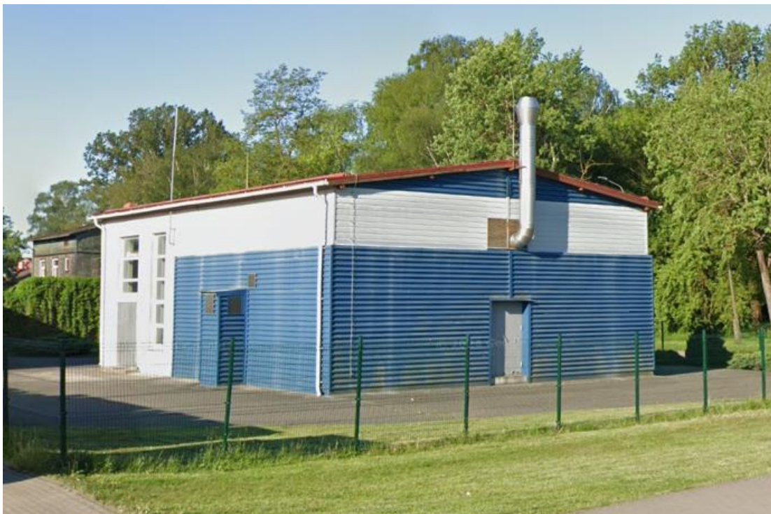
Attēls 2. Paredzētās saules elektrostacijas ēkas fotoattēls Zemnieku ielā 20, Liepājā
